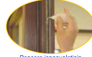
Pencere ispanyoletinin yağlanması
