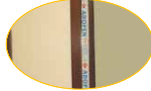
Doğrama üzerindeki koruyucu folyo
